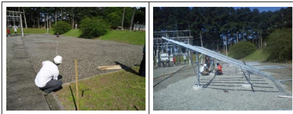
Figura 12: Etapas intermediárias na implantação dos painéis.
