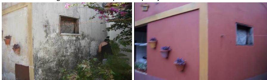
Figura 6 Antes e depois da aplicação da tinta Tons da Terra
