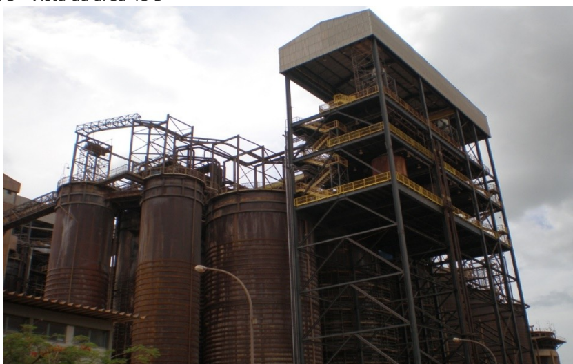
Figura 3 - Vista da área 48 B
