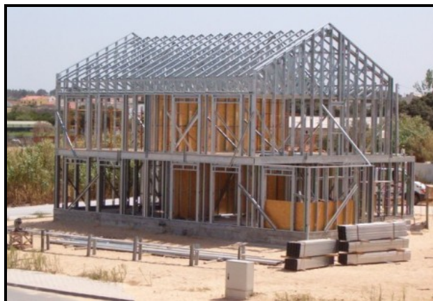
Figura 1 – Estrutura em sistema Light Steel Frame
