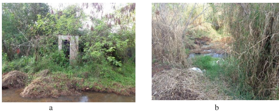
a b Figura 7 – (a) e (b) Área inundada provocada pela condição atual do relevo e precipitações Fonte: Ambiental SS (2016).
