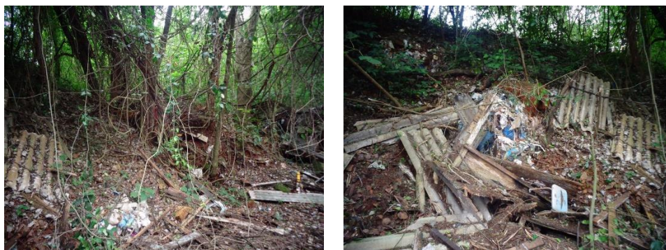
Figura 2 - Declive acentuado com risco de recalque e desabamento Fonte: Ambiental SS (2016).
