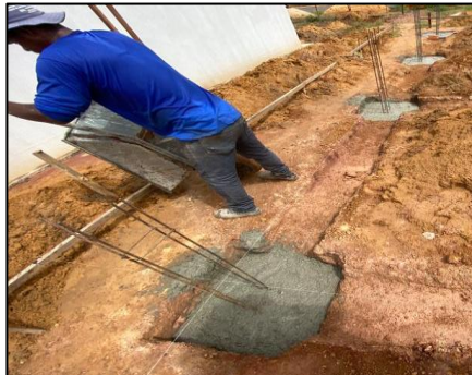
Figura 25 - Concretagem das sapatas após o lastro magro.
