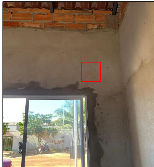
Figura 20 - Marcação para tomada.
