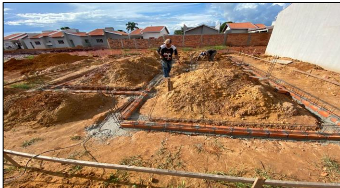
Figura 26 - Lastro magro de concreto/alvenaria de nivelamento.
