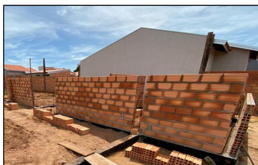
Figura 33 - Levantamento da alvenaria cerâmica.
