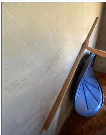
Figura 35 - Execução uniforme do reboco.
