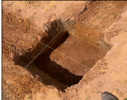
Figura 24 – Escavação para as sapatas.
