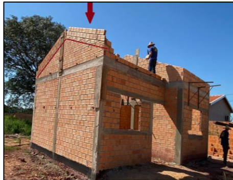
Figura 22 - Acréscimo de tijolos para o oitão.
