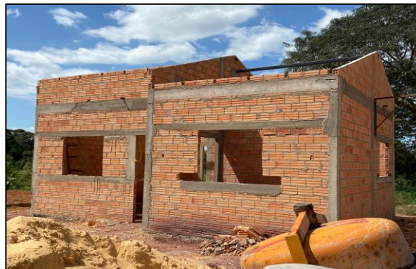
Figura 14 – Execução da contraverga na janela frontal.
