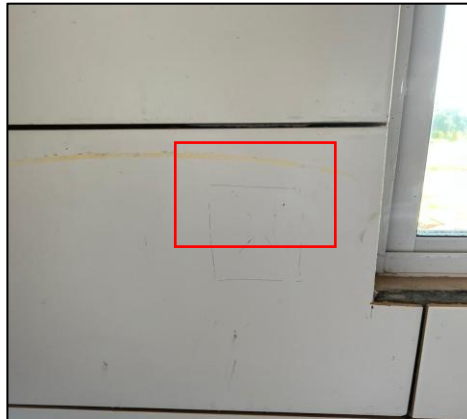
Figura 21 - Marcação para tomada.
