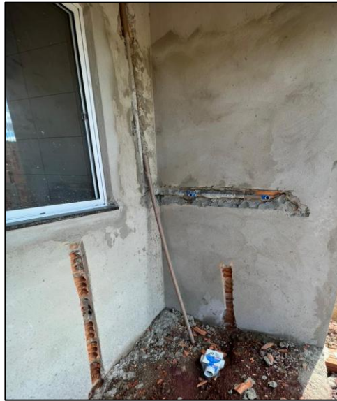
Figura 19 - Corte do reboco para instalação hidráulica.
