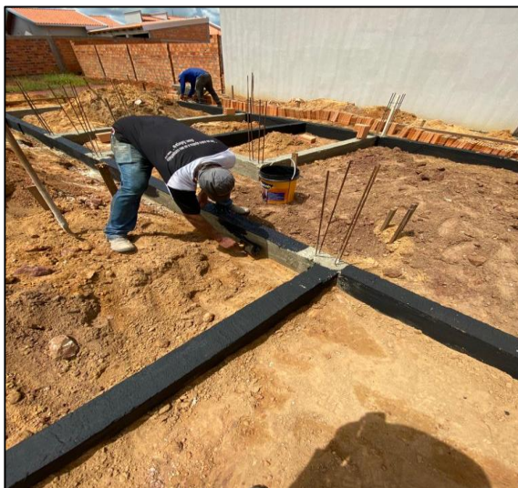
Figura 30 - Impermeabilização das vigas baldrame.
