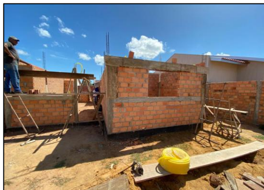
Figura 34 - Execução de vergas e contravergas.
