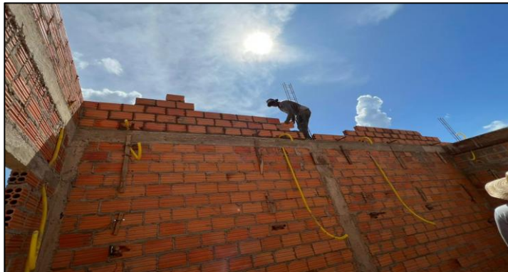
Figura 37 - Passagem dos conduítes sem quebrar as vigas.
