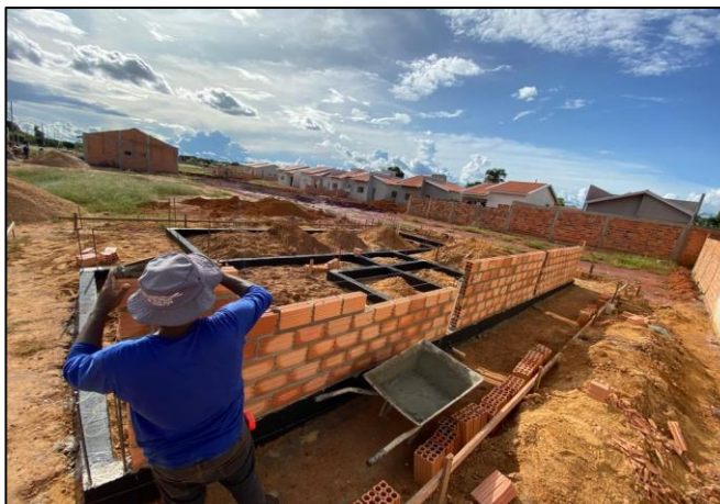
Figura 31 - Execução da alvenaria.
