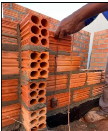
Figura 32 - Alinhamento vertical com prumo.
