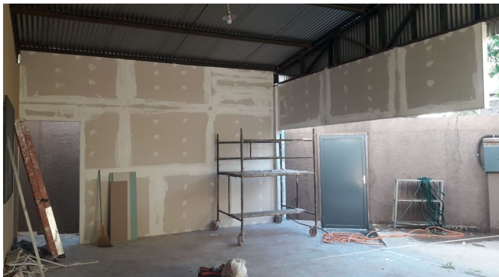
Figura 3 – Paredes de drywall
