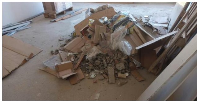
Figura 4 – Acondicionamento dos RCC
