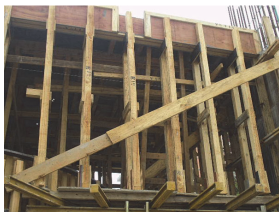
Figura 3 – Utilização no canteiro de obras
