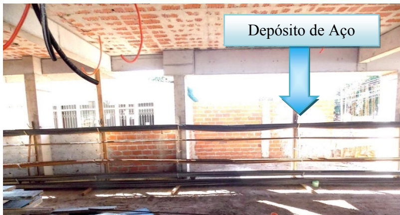
Figura 5 – Acondicionamento de aço no canteiro.
