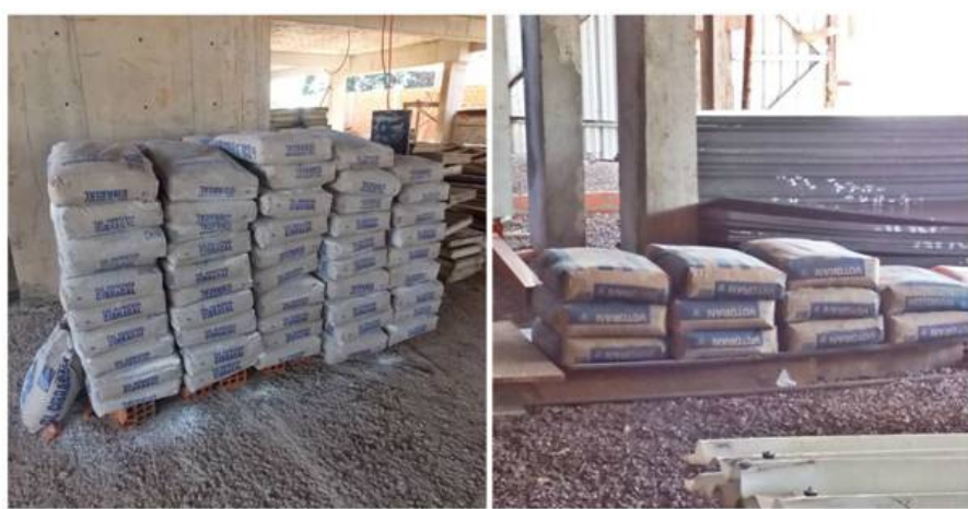
Figura 4 – Acondicionamento sacos de cal e cimento no canteiro.
