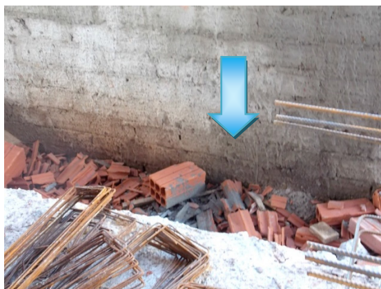
Figura 2 – Local destinado ao acondicionamento dos resíduos, classe A.
