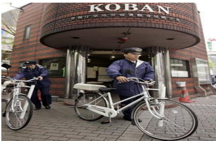
Figura 02 – Prédio de um koban padrão em um bairro de Tóquio, Japão
