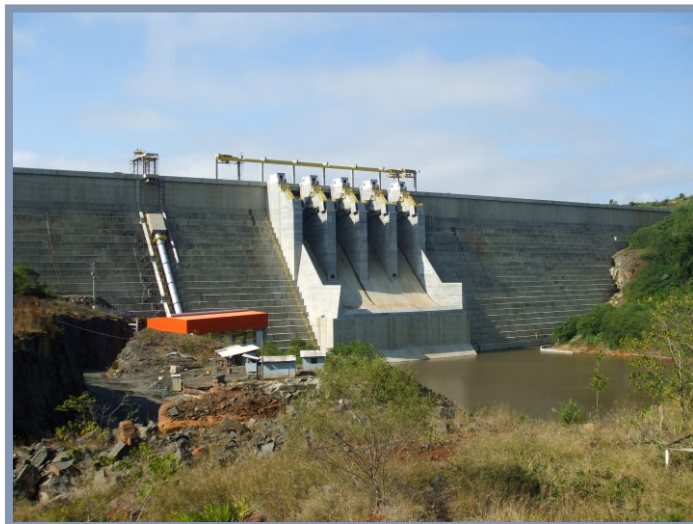
Figura 4: Barragem vista da margem direita (jusante)
