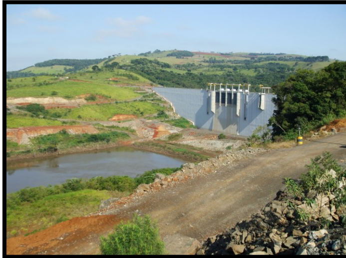
Figura 3: Barragem vista da margem direita (montante)
