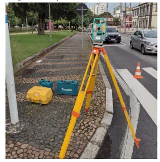
Figura 11 – Estação total instalada no vértice A016
