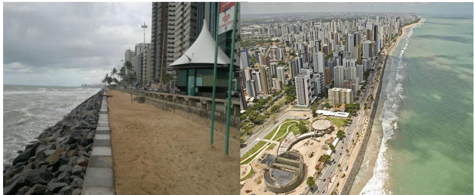
Figura 9 - Obras de contenção na praia de Boa viagem 2012
