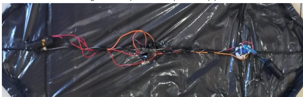
Figura 5 – Dispositivos acoplados na pipa
