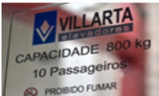
Figura 6 – Placa de sinalização de capacidade
